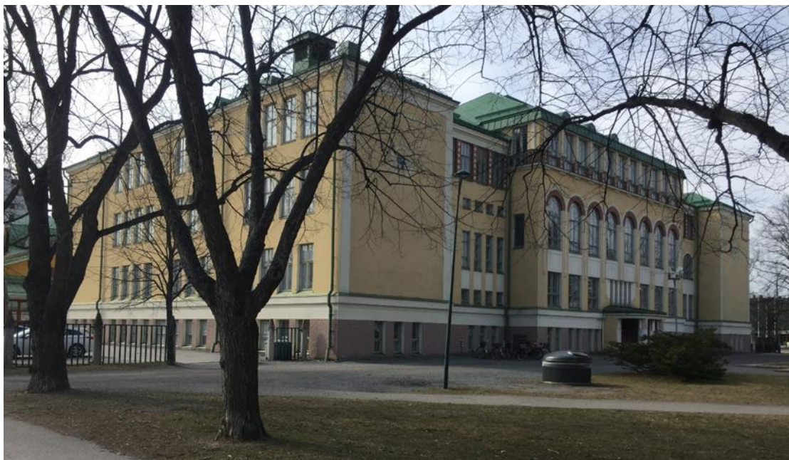
Kuva 7 Cygnaeuksen koulun pohjoinen julkisivu v. 2020. Helene Kaarnametsä
