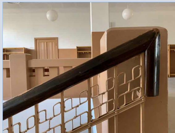
Puinen käsijohde on kiinnitetty koristeelliseen metallikaiteeseen.
