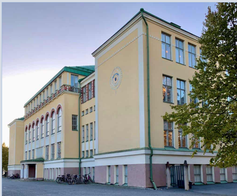
Keskiosaa reunustavat luokkasiivet ovat kellarikerrosta lukuun ottamatta pohjoissivulla aukottomat.
