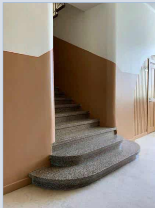
Mosaiikkibetonipintaiset portaat toisen kerroksen luokka-aulasta välikerrokseen.
