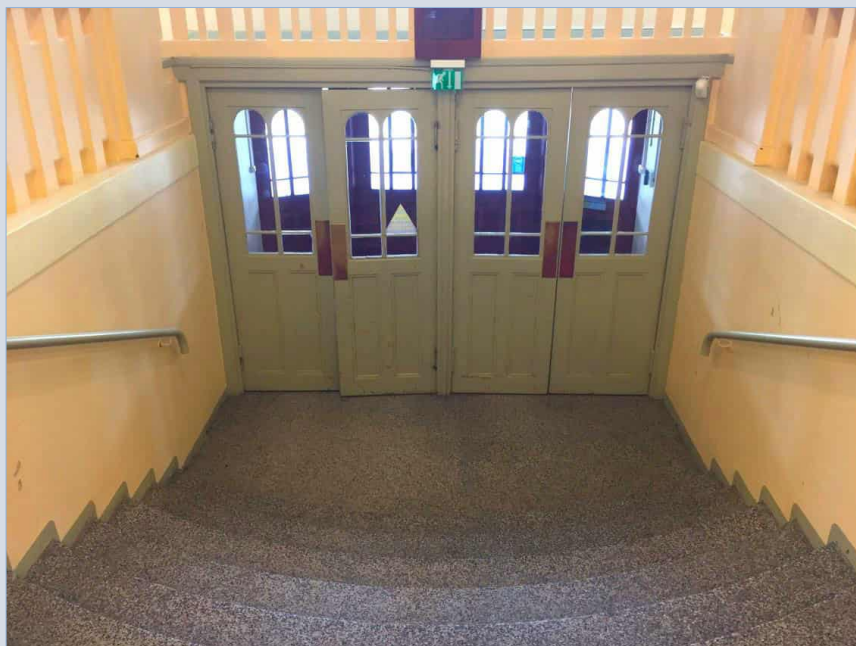
Sisäänkäynnin puuovet ja kaarevat mosaiikkibetoniaskelmat.
