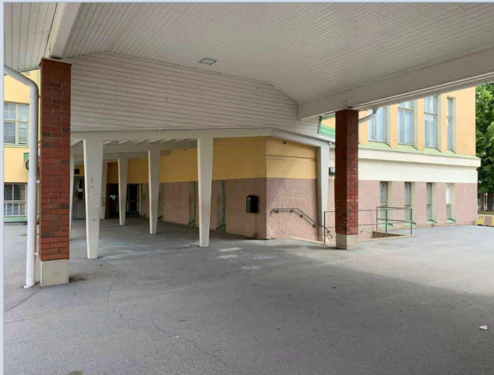
Alkuperäinen, kapenevien betonipilareiden kannattama 1950-luvun katos on säilytetty osittain. Tiilipilarit kuuluvat vuonna 2010 rakennettuun osaan.
