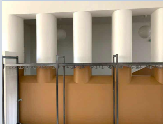
Rajaava, muurattu rakenne luokka-aulan ja pääportaikon välissä.
