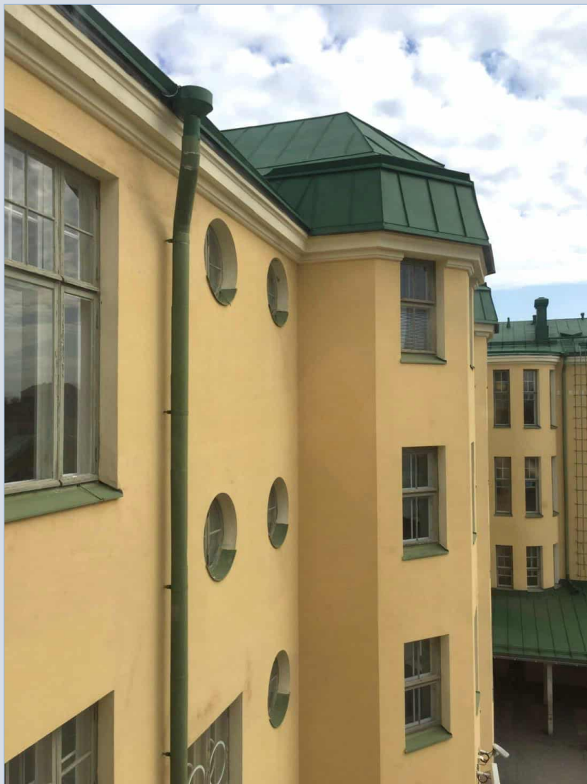
Koulurakennuksen pihajulkisivua erkereineen.
