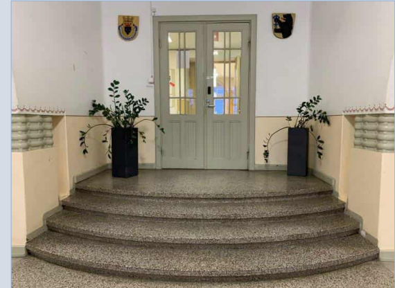
Mosaiikkibetoniaskelmat koulun kansliaan ja opettajainhuoneisiin.
